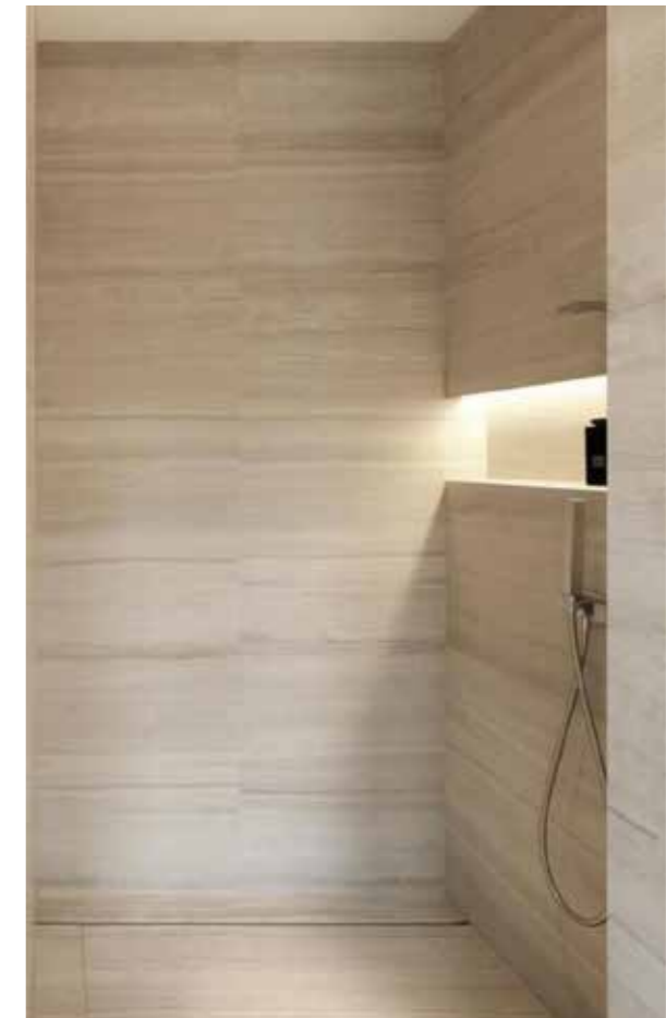
Hornacina de obra en duchas con led integrado
